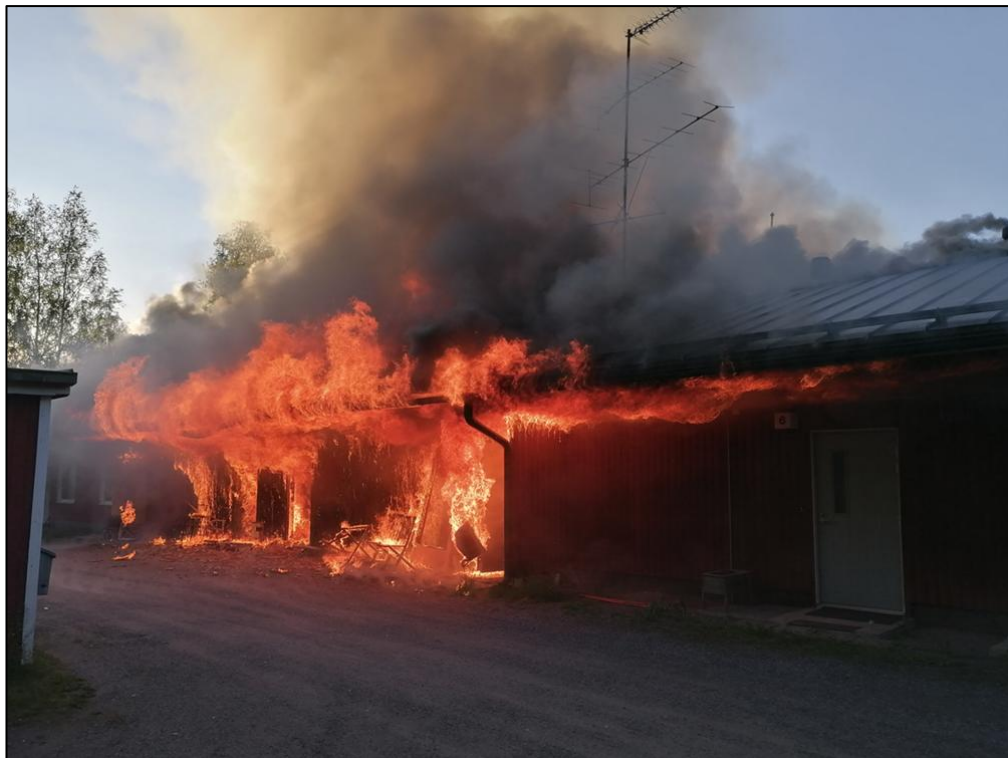
Kuva 3. Räystäsrakenteella on merkittävä vaikutus palon leviämisessä (Kuva: Simo Päivärinta)
