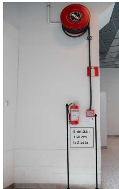
Bild 9: Placeringshöjden av släckarhantaget samt snabbrandpostens slangända från golvytan.
