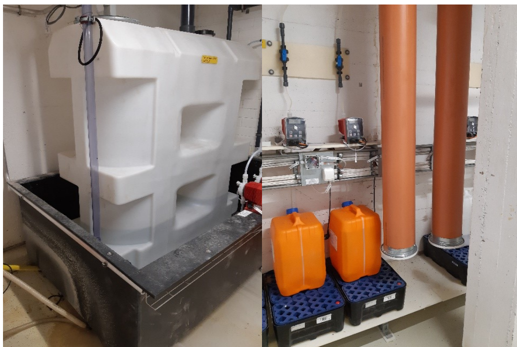
Kuva 1. Vasemmalla natriumhypokloriittisäiliö, ja oikealla rikkihappoastiat kestomuovisissa valuma-altaissaan. Rikkihappoastioiden vieressä sijaitsevat poistoilmanvaihtoputket. Sähköasennuksen kotelointi on puutteellinen.
