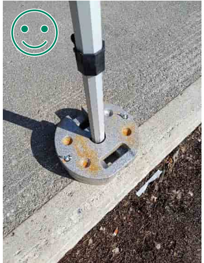
Kuva 2 HYVÄ TAPA. Molemmat painot kiinnitetty siipimutterilla molemmin puolin. Hevosenkämpainot vastakkain, jolloin tolppa ei pääse irtoamaan rakenteen liikuessa. Kulmatolpan maajalan tulee kestää kyseinen paino.
