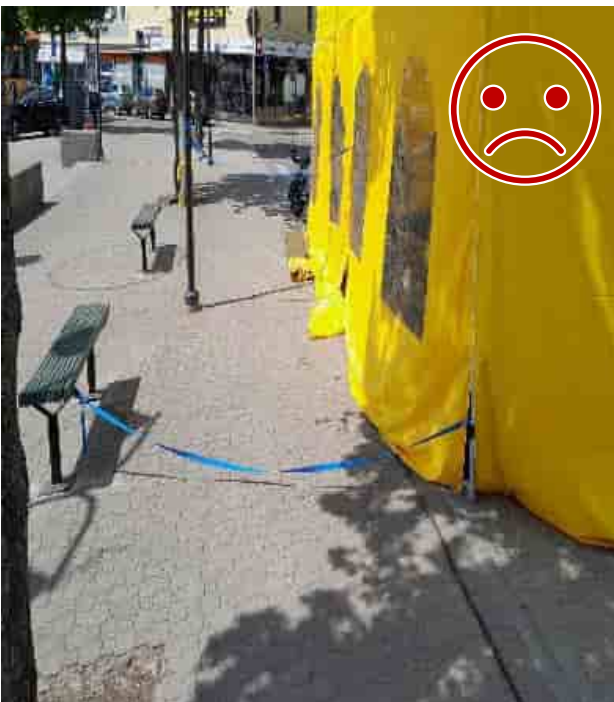
Kuva 12 EI NÄIN. Vaakasuunnan kiinnitys ei estä telttaa nousemasta ilmaan. Liina aiheuttaa lisäksi kompastumisvaaraa.
