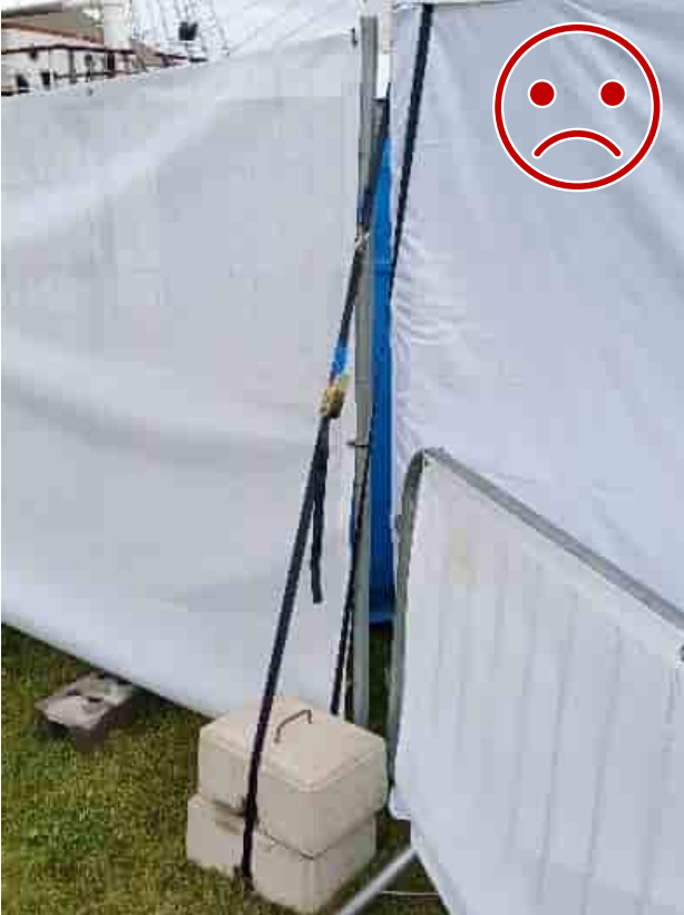
Kuva 11 EI NÄIN. Painoja ei ole lukittu liinaan tai toisiinsa. Pino kaatuu eikä liina pidä rakenteen liikkessa.
