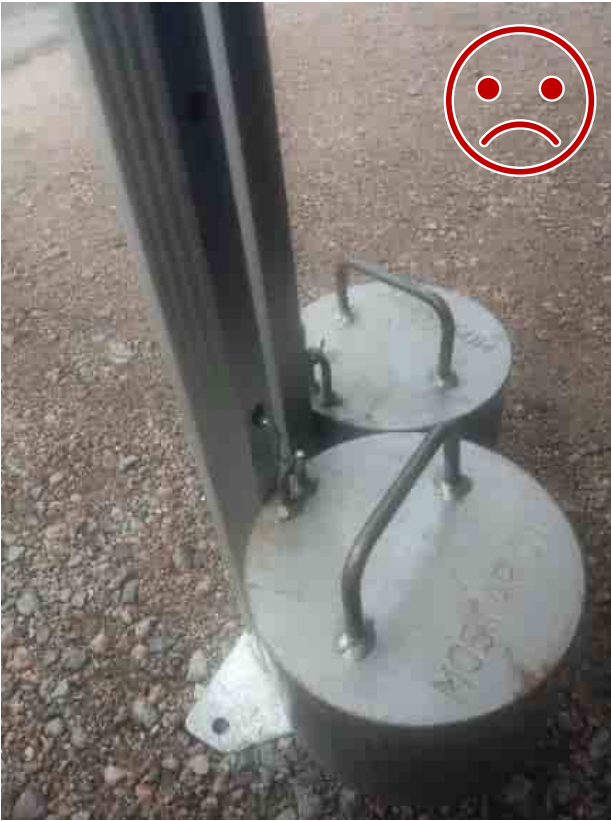
Kuva 9 EI NÄIN. Teräskoukku ei lukkiudu rakenteeseen. Lisäksi teräs leikkaa alumiinia nosteen ravistellessa telttaa.
