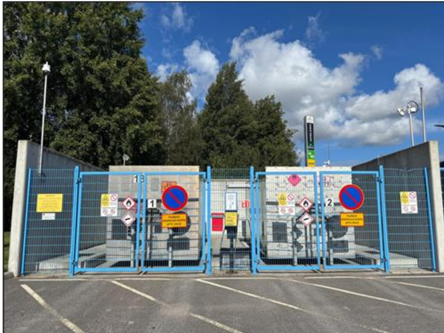
Bild 1. Översiktsbild över containerområdet vid CNG-tankstationen.
