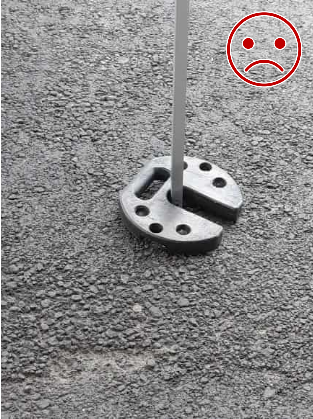
Bild 3 INTE SÅ HÄR. Vikten är inte låst vid konstruktionen. Det är nödvändigt att lägga en andra vikt på andra sidan samt att låsa vikterna vid varandra.
