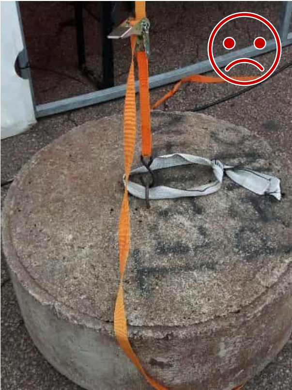
Bild 7 INTE SÅ HÄR. S-kroken är inte låsbar. Kroken lossnar när konstruktionen rör sig.
