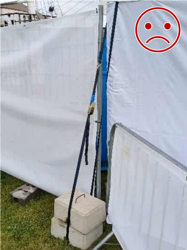
Bild 11 INTE SÅ HÄR. Vikterna är inte låsta vid linan eller varandra. Traven välter och linan håller inte när konstruktionen rör sig.
