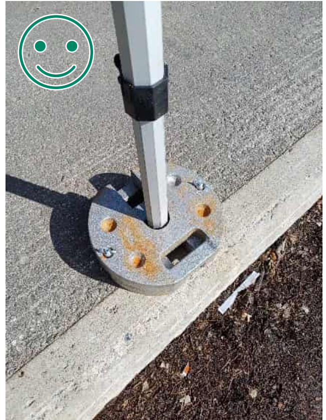
Bild 2 BRA PRAXIS. Båda vikterna har fästs med en vingmutter på båda sidor. Hästskovikterna mot varandra, varvid stolpen inte kan lossna när konstruktionen rör sig. Vinkelstolpens jordfot ska tåla vikten i fråga.
