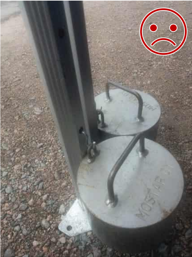
Bild 9 INTE SÅ HÄR. Stålkroken låser sig inte vid konstruktionen. Dessutom stålet skära aluminiumet när lyftet skakar tältet.
