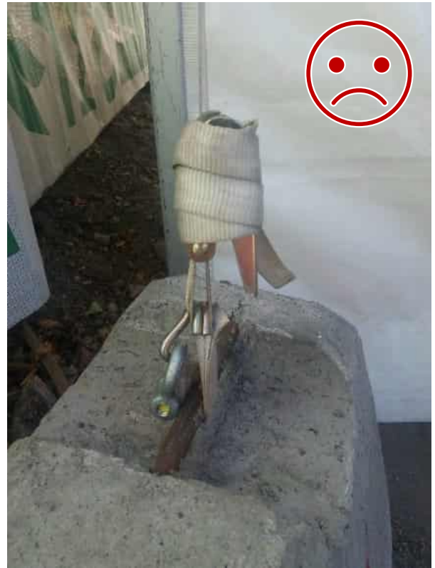
Bild 6 INTE SÅ HÄR. Kroken är inte låst, ska vara låst med sockel vid fästpunkten från kroken.
